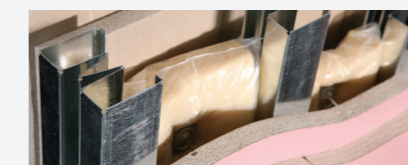
W-STEEL 시스템 세대간 벽체에 단일스테드로 2시간 내화 및 1등급의 차음성능을 갖춘 시스템
